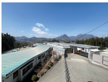
3月からB棟解体が始まりました。1年後が楽しみです
