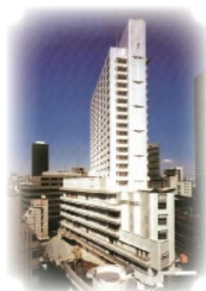
港区立障害保健福祉センター
