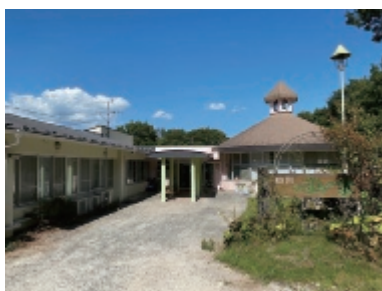
白州いずみの家外観
