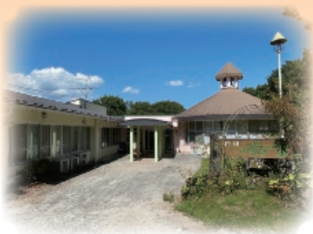
白州いずみの家外観
