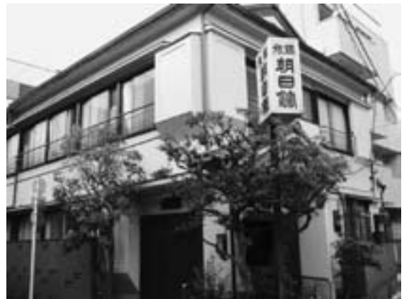
ふるさとの会が運営している「ふるさと旅館朝日館」の外観
