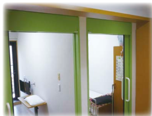
間仕切り改修後の個室
