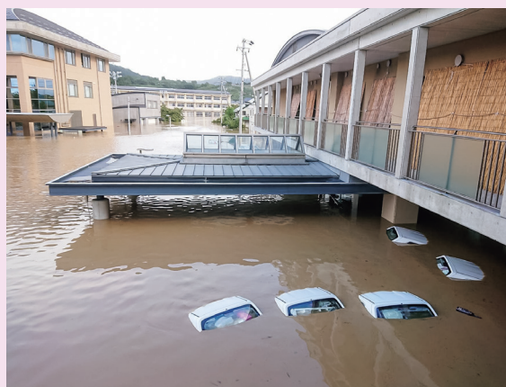
台風19号で浸水した豊野事業所
