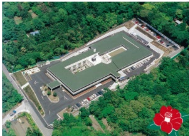
大島老人ホームの全景
