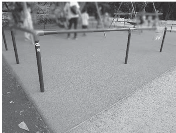
転んでも刺激を吸収してくれるゴムチップ舗装
